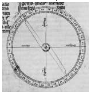
Компас із трактату Перегріна «Послання про магніт» (1269).
